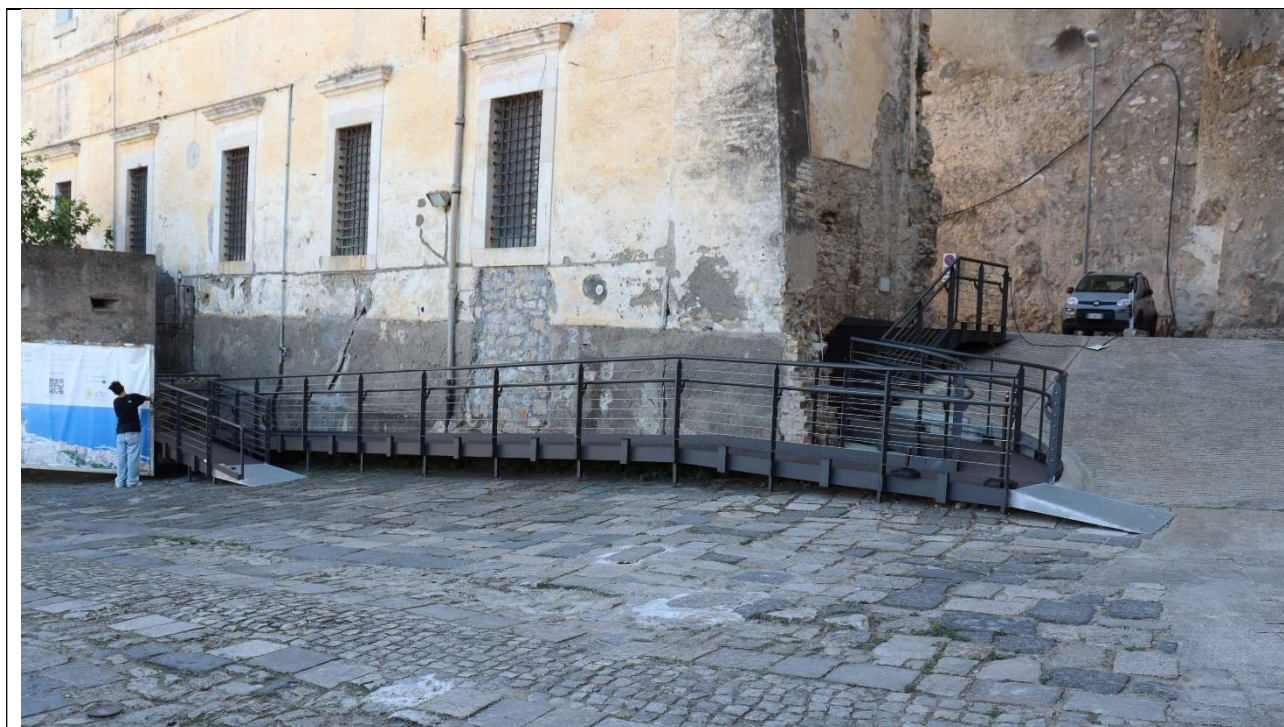
Fig. 2 – Rampa metallica che consente di superare il dislivello presente all'ingresso. La struttura, dotata di parapetti laterali e pianerottoli di sosta, collega l'area di parcheggio e l'ingresso agevolato, affiancandosi alla pavimentazione storica in basolato.
