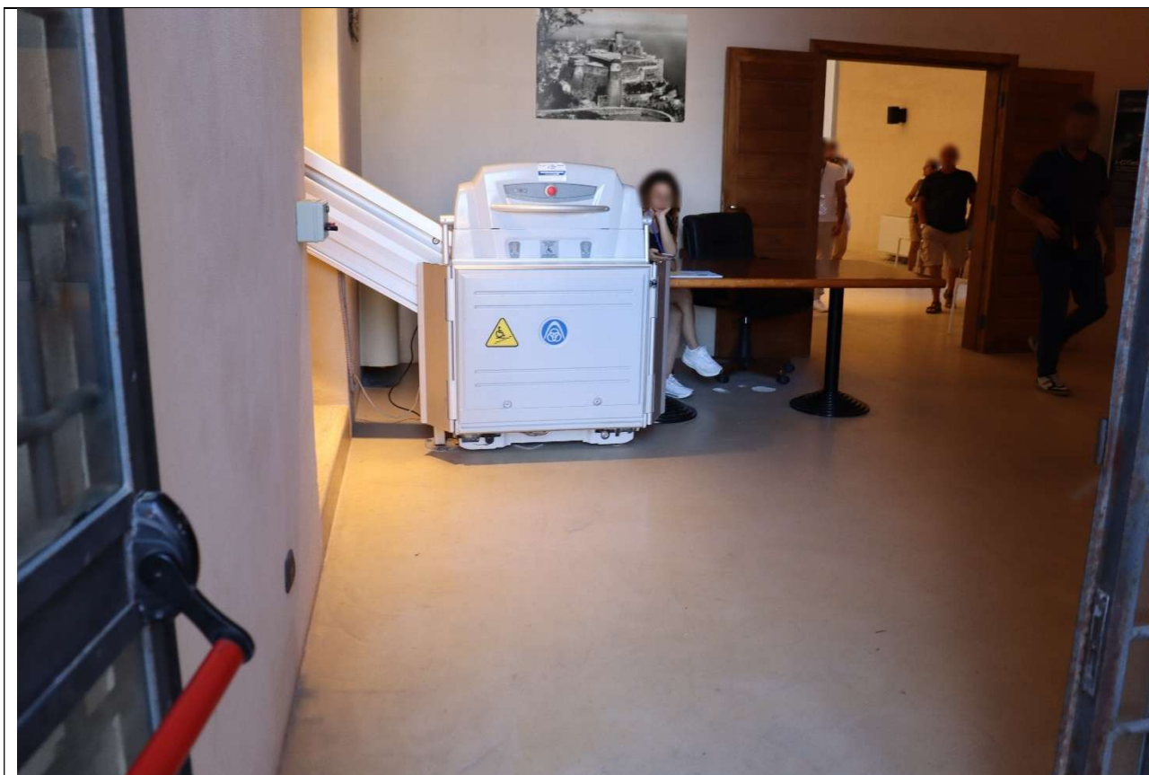
Fig. 4 - Area di accoglienza interna del Castello Angioino di Gaeta, attualmente organizzata con un tavolo informativo in prossimità del montascale. Mancano un vero e proprio guardaroba, postazioni ribassate per utenti in carrozzina e sistemi di orientamento e comunicazione accessibile.
