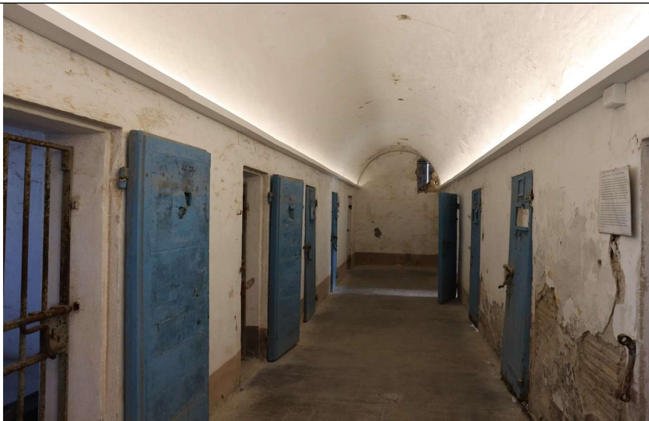
Fig. 1 – Corridoio delle celle piemontesi con pavimentazione storica
