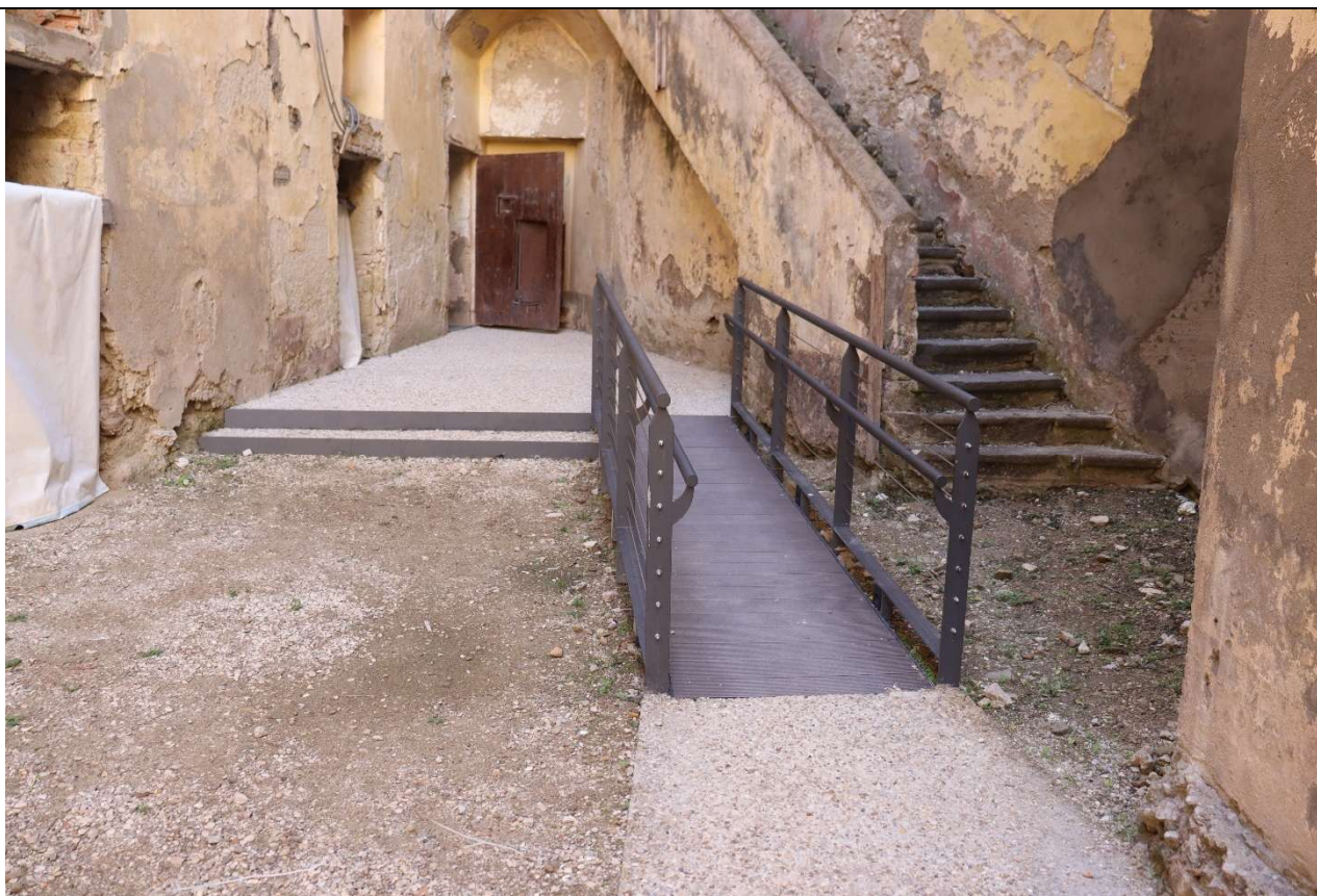
Fig. 1 – Rampa metallica di collegamento al percorso delle celle borboniche
