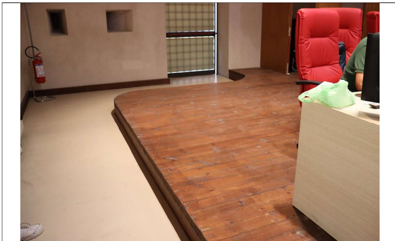
Fig. 2 – Palco ligneo rialzato all'interno della sala convegni, attualmente privo di rampe di collegamento che ne consentano l'accesso a persone con ridotta mobilità
